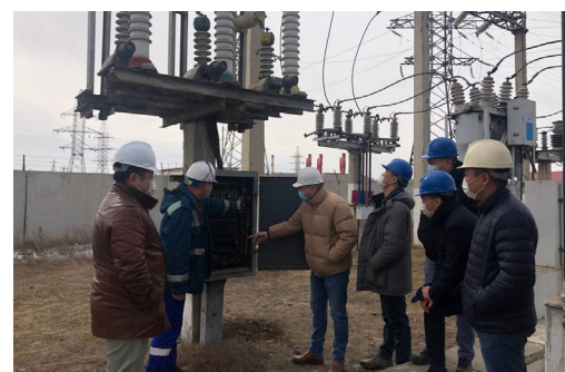
Хүчдэлийн трансформаторын шкафанд хоёрдогч хэлхээний шуурхай ажиллагааны бичиглэл тулгаж байгаа нь
